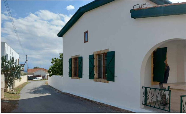
Bakım ve Onarımı Gerçekleştirilen Dağyolu Camii
