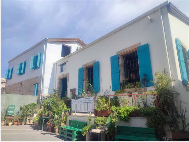
Bilal Ağa Vakfı'na Ait Binaların Restore Edilerek Kültür Merkezine Dönüştürülmesi
