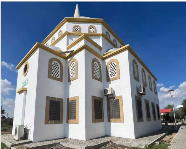
Geçitkale Camisi'ne Gerçekleştirilen Bakım ve Onarım
