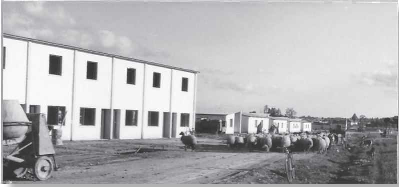
Göçmenköy'de inşa edilen altılı teras tipi göçmen evleri.
