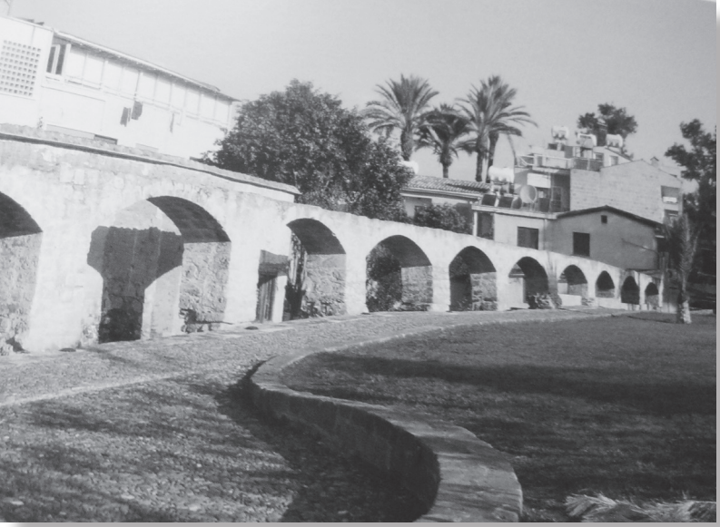
Lefkoşa Suriçi'ndeki Vakıflar'a ait su kemerleri.
