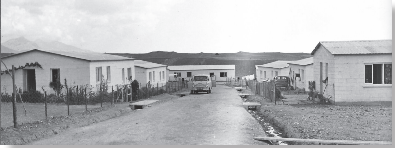
Dağyolu'nda (Fota) inşa edilen göçmen evleri.
